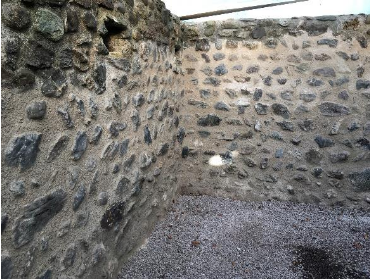
Abb.41: Neu ausgefugt und Mörtel zurückgekratzt
