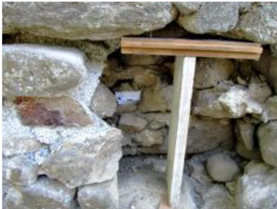
Aus der Mitte der Mauer wurde eine Probe des vermutlichen Konstruktionsmörtels entnommen.
