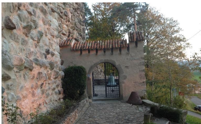
Abb.27: Burgtor Aussenseite nach der Sanierung
