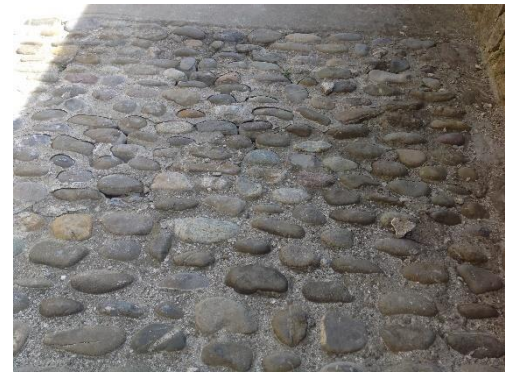
Abb.17: Einzelne lose Pflastersteine
