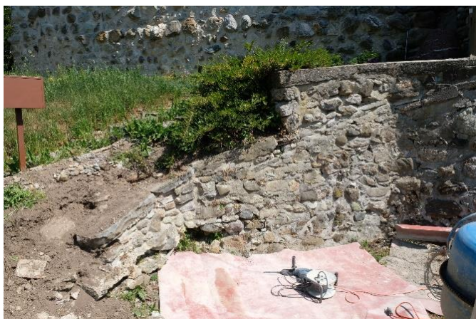
Abb.56: Mauerabschnitt während dem Rückbau
