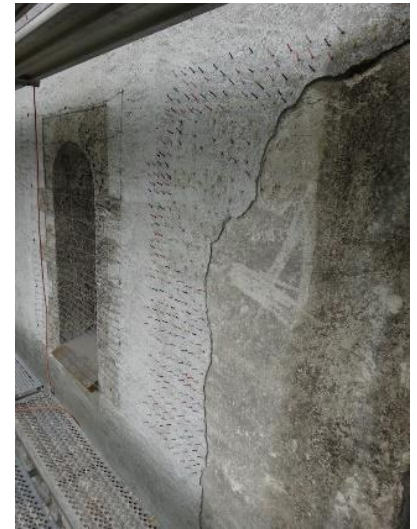
Abb.23: Trinkhalme zum Einbringen von Wasserglas
