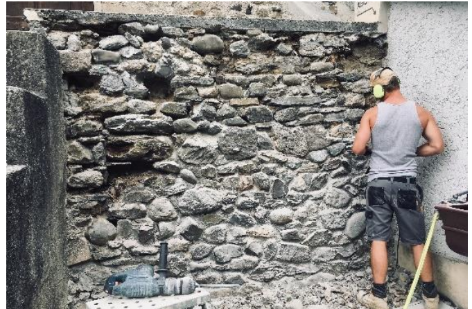
Abb.52: Entfernen der Fugen
