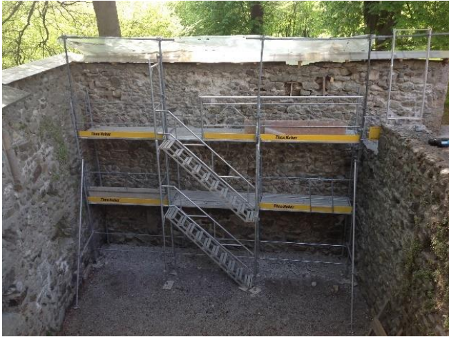
Abb.30: Einzelne Segmente der Mauer wurden geöffnet.
