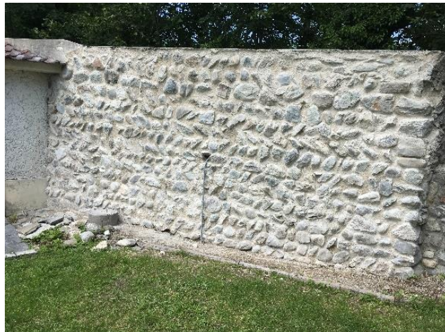
Abb.43: Fischgratmauerwerk neu ausgefugt
