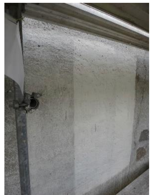
Abb.24: Bemusterung Schlämme und Farbe
