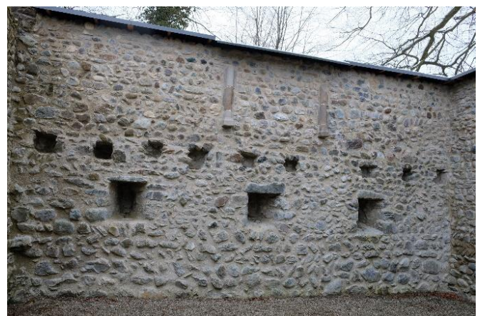
Abb.33: Fertig instand gestellte Ruinenmauer
