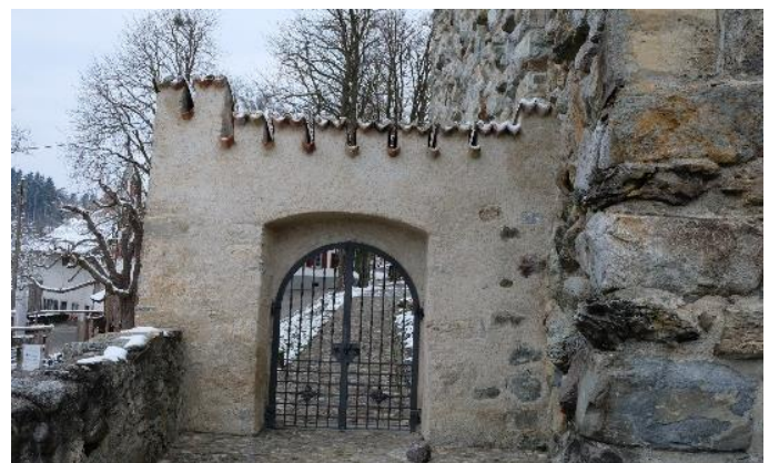
Abb.28: Burgtor Innenseite nach der Sanierung
