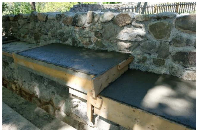
Abb.48: Abdeckplatten frisch in Schalung
