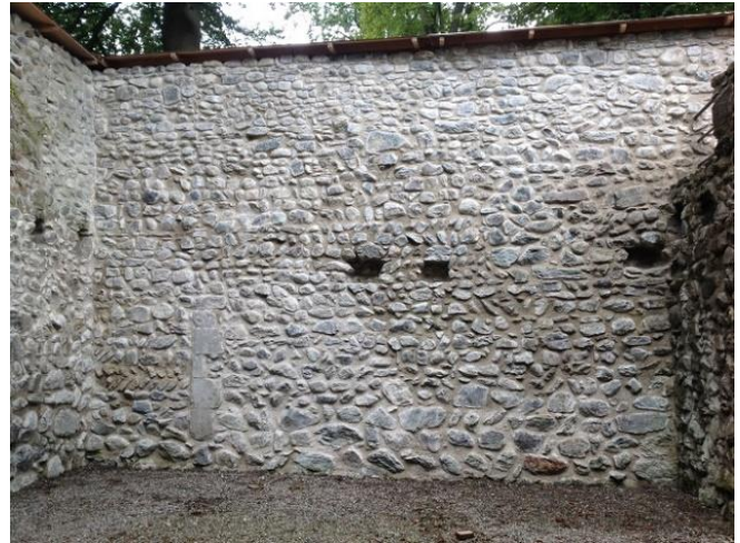
Abb.31: Die neu aufgemauerten Abschnitte fügen sich gut in den historischen Bestand
