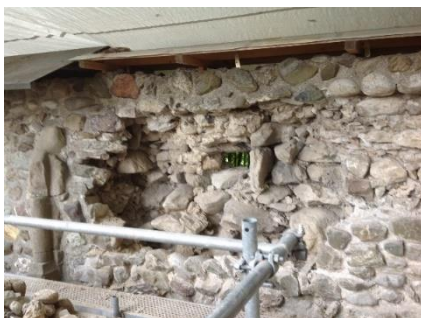
Abb.32: Offene Mauer auf der Innenseite der starken Wölbung
