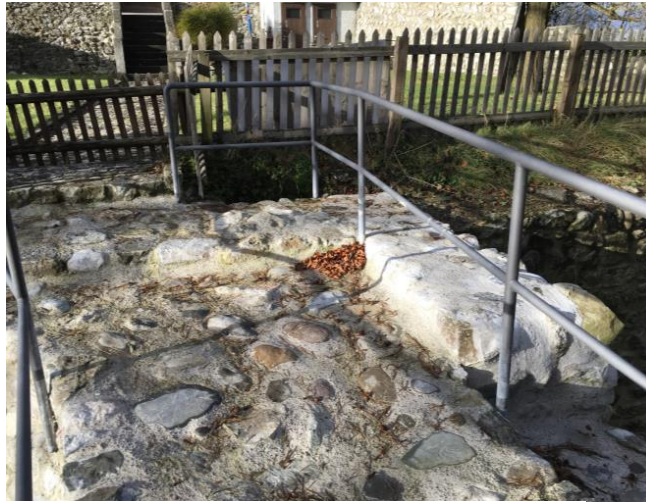
Abb.37: Neue Abdeckung über Kellerabgang
