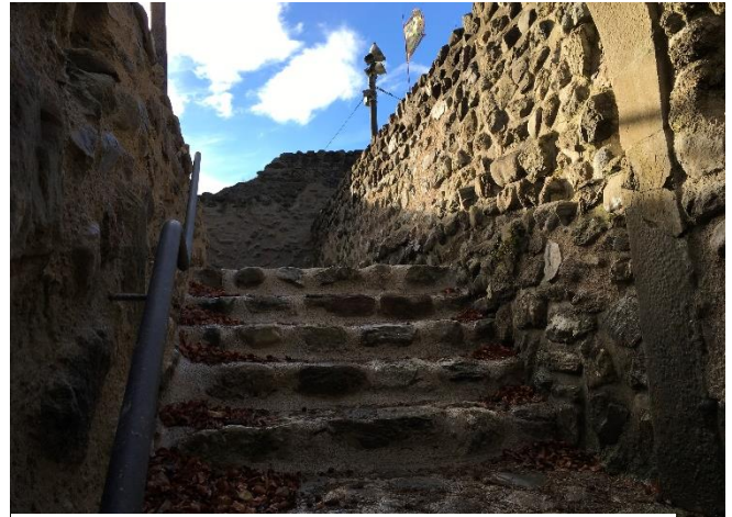
Abb.39: Fertig Instand gestellte Treppe
