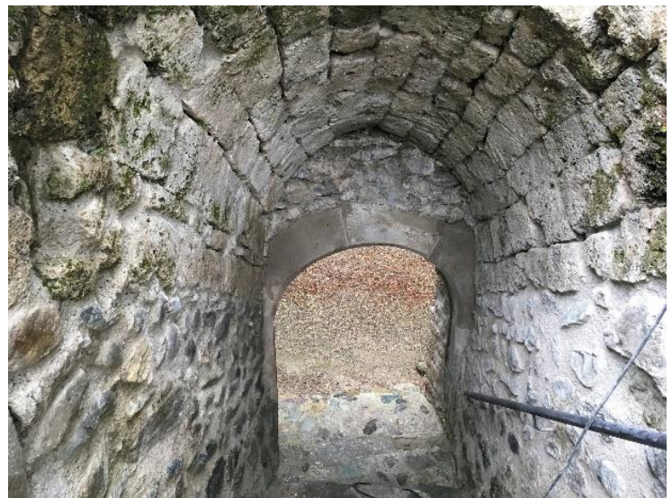
Abb.55: Sandsteinbogen aufgemörtelt und farblich angepasst
