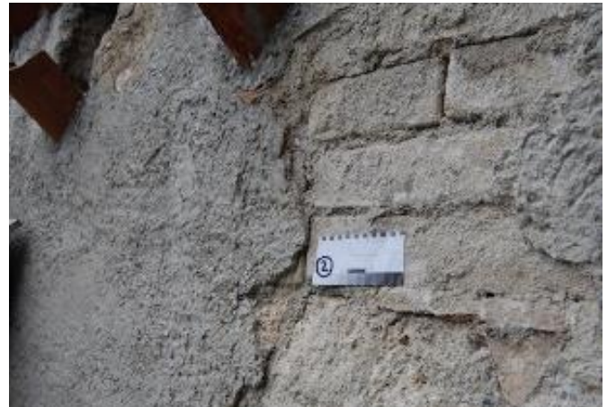
Abb.14: Grosse Putzabplatzungen durch Frosteinwirkung
