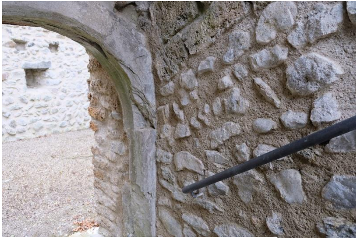
Abb.38: Fertige Oberfläche an Wand Kellerabgang
