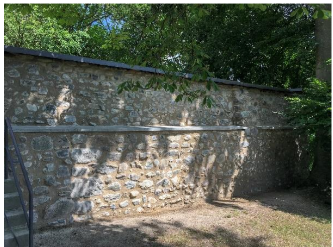
Abb.50: Ansicht der Mauer nach der Sanierung
