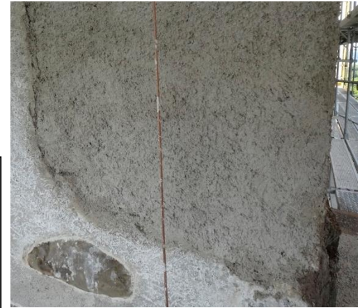
Abb.25: Grundputz bereit für Deckputzapplikation
