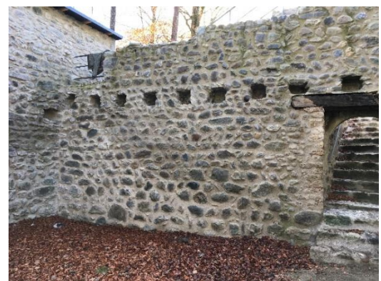
Abb.35: Fertig Instand gestellte Ruinenmauer
