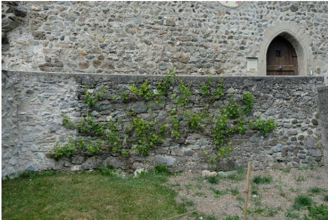
Abb.51: Ruinenmauer vor Sanierung
