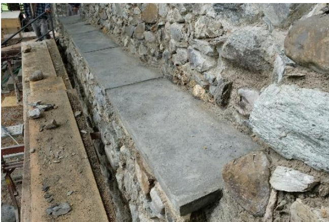
Abb.47: Neue Abdeckplatten nach dem Ausschalen
