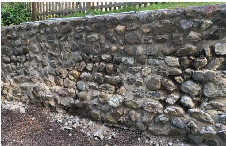
Abb.40: Sondageöffnungen bei Mauer Grau
