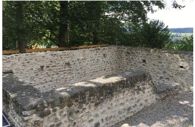
Abb.54: Fertig instand gestellte Ruinenmauern
