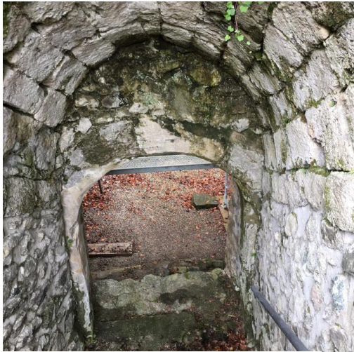
Abb.36: Der Kellerabgang vor der Sanierung
